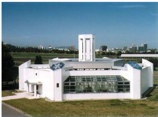
<クリオトロン全景> 正面のガラス温室の地下で恒温環境を制御可能
