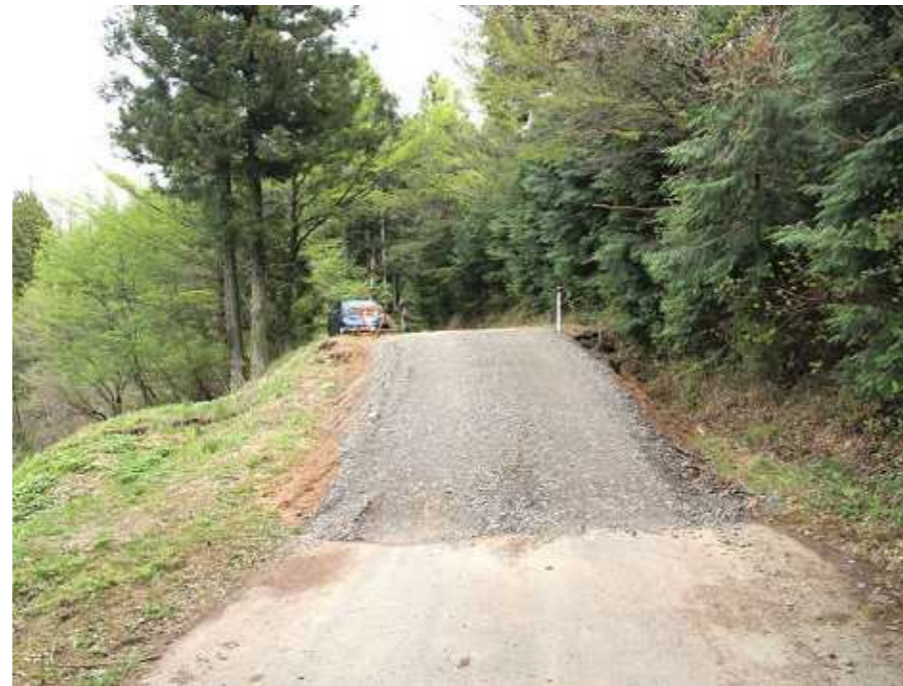
写真5：地震断層により道路に約1mの段差が生じた。すでに応急復旧が完了しており、通行は可能。
