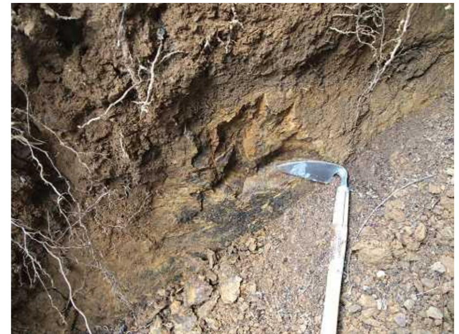
写真8：断層面には、強風化した片岩が露出し、条線が認められる。
