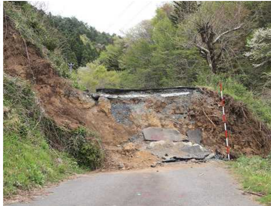
写真9：地震断層により道路に約1.8mの段差が生じている。鉛直変位はこの周辺で最大であるが、水平変位は小さい。
