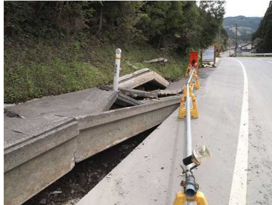
写真1：地震断層により道路及び排水溝が損傷を受けている。排水溝の直下で断層ガウジを確認した（写真2，写真3参照）。
